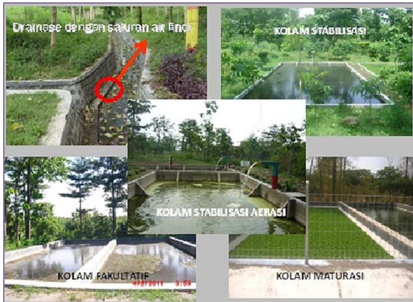
Gambar 3.25 Instalasi Pengolahan Lindi
