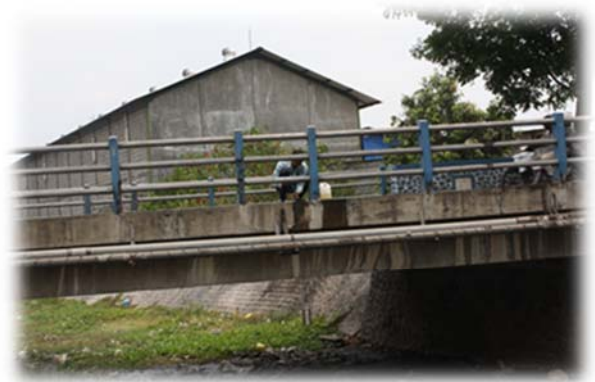
Saluran Gude Ploso Dam Tambakberas
