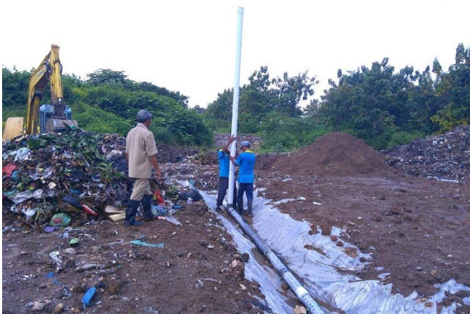
Pemasangan Pipa Gas Methan
