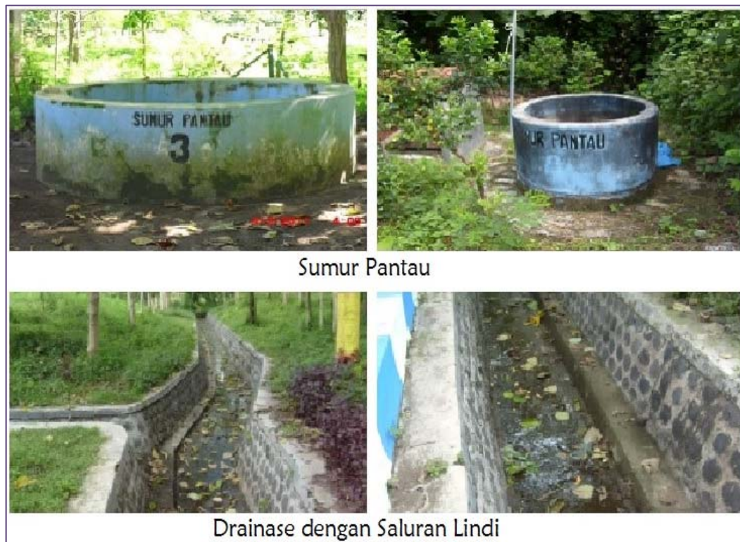
Gambar 3.24 Sumur Pantau dan Drainase dengan Saluran Lindi
