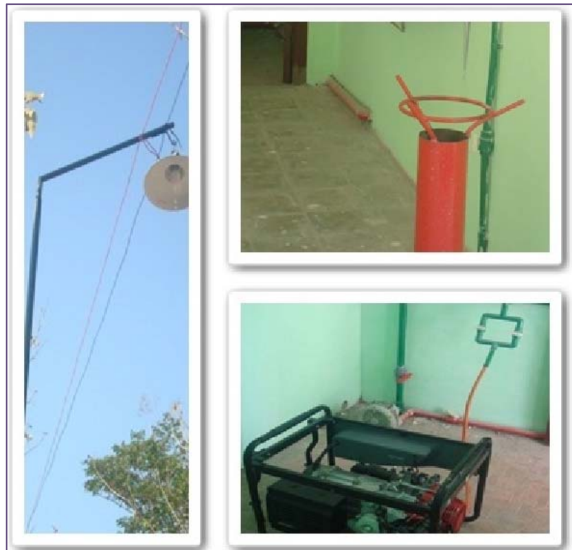
Gambar 3.30 Penggunaan gas metan TPA untuk lampu penerangan dan kompor gas
