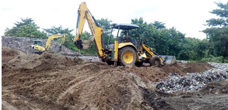
Pelapisan Tanah Urug
