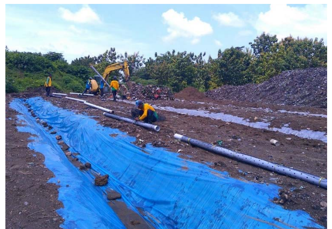
Pemasangan Jaringan Perpipaan Lindi
