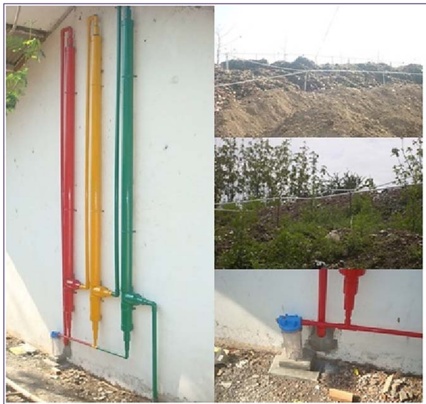
Gambar 3.29 Penggunaan gas methan TPA untuk sumber energi genset
